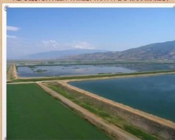
ΑΕΡΟΦΩΤΟΓΡΑΦΙΑ ΤΑΜΙΕΥΤΗΡΑ Α & Β ΚΑΛΑΜΑΚΙΟΥ
