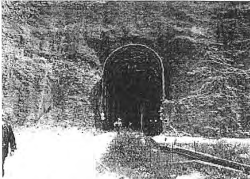
Εικόνα 6 – Φωτογραφία του μετώπου εισόδου στην σήραγγα.
