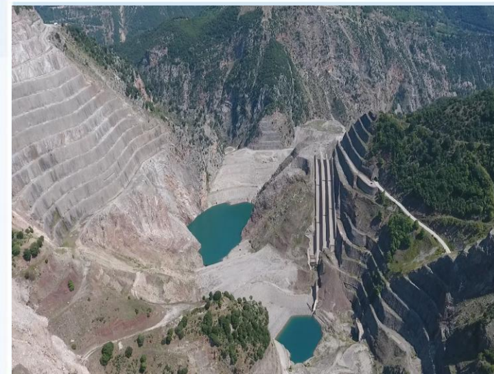
Κατάντη άποψη φράγματος
