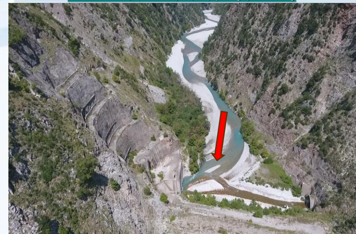
Ανάντη άποψη φράγματος
