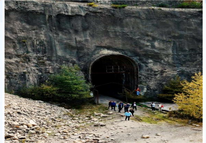
Είσοδος σήραγγας (Πετρωτό)
