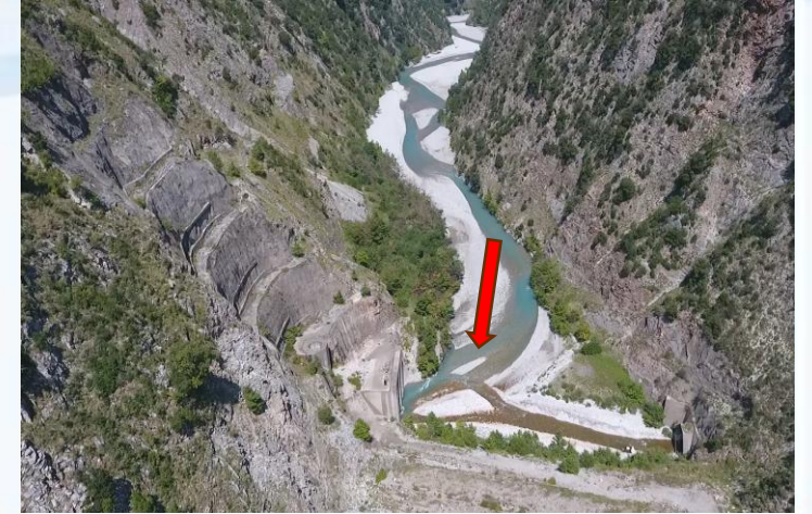
Ανάντη άποψη φράγματος
