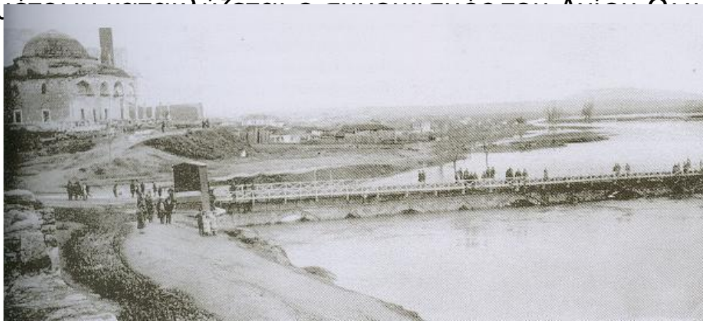
Η Γέφυρα του Αλκαζάρ σε πλημμύρες του Πηνειού
