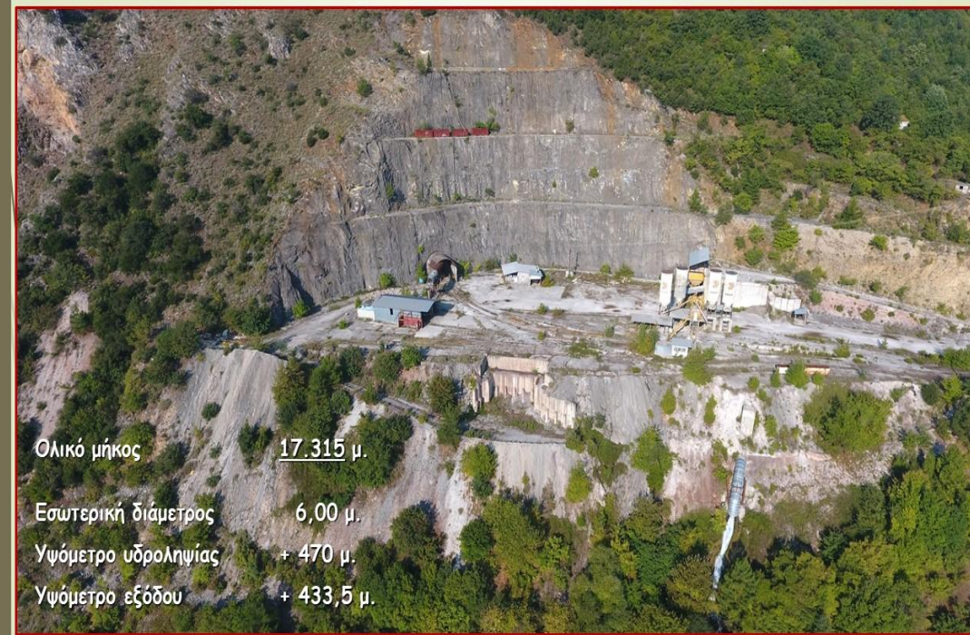
Γενική άποψη εξόδου σήραγγας μεταφοράς (Πευκόφυτο)
