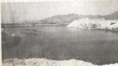
Ενα απ' τα φράγματα στο Λαγόνι, όπου φαίνεται και η διακλάση
