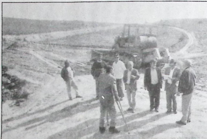
Προχωρούν οι εργασίες για το φράγμα στο Μεγάλο Ελευθεροχώρι
