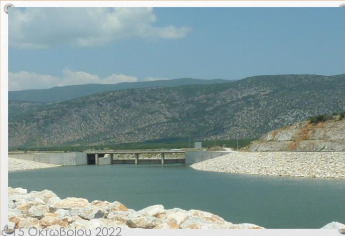
ΑΠΟΨΗ ΚΑΤΑΝΤΗ ΤΕΧΝΙΚΟΥ ΕΙΣΟΔΟΥ ΣΥΛΛΕΚΤΗΡΑ Σ3
