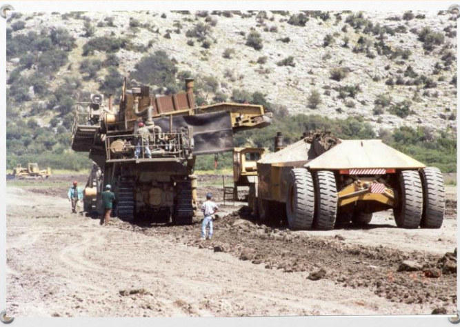
ΧΩΜΑΤΟΥΡΓΙΚΕΣ ΕΡΓΑΣΙΕΣ ΚΑΤΑΣΚΕΥΗΣ ΤΑΜΙΕΥΤΗΡΑ ΚΑΡΛΑΣ
