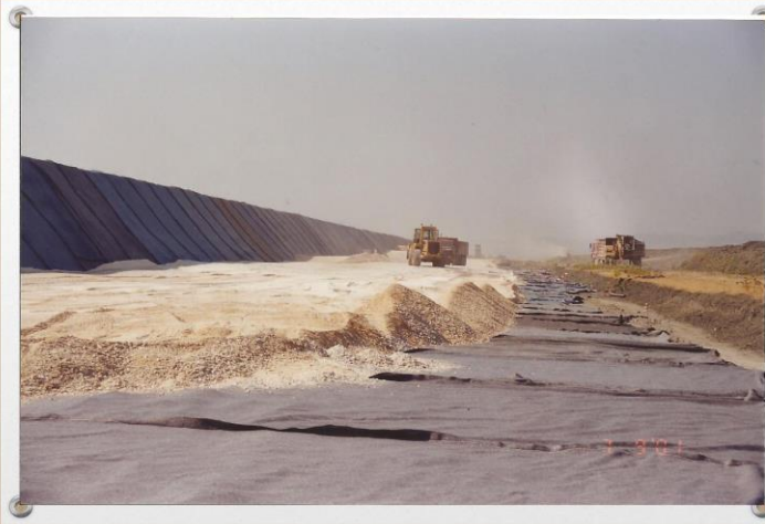
ΕΡΓΑΣΙΕΣ ΚΑΤΑΣΚΕΥΗΣ ΑΝΑΧΩΜΑΤΩΝ ΤΑΜΙΕΥΤΗΡΑ ΚΑΡΛΑΣ
