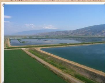
ΑΕΡΟΦΩΤΟΓΡΑΦΙΑ ΤΑΜΙΕΥΤΗΡΑ Α & Β ΚΑΛΑΜΑΚΙΟΥ
