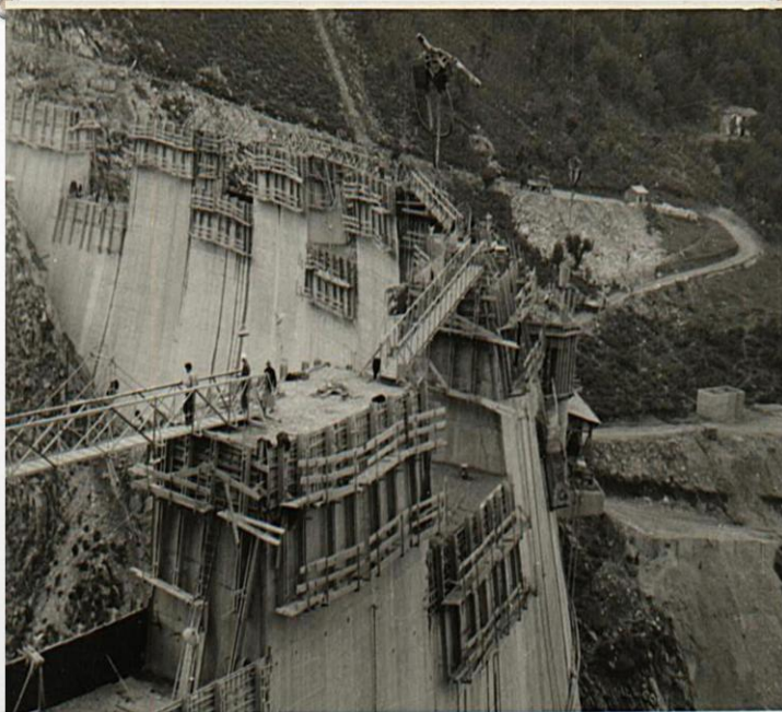
ΕΡΓΑΣΙΕΣ ΚΑΤΑΣΚΕΥΗΣ ΦΡΑΓΜΑΤΟΣ ΤΑΥΡΩΠΟΥ
