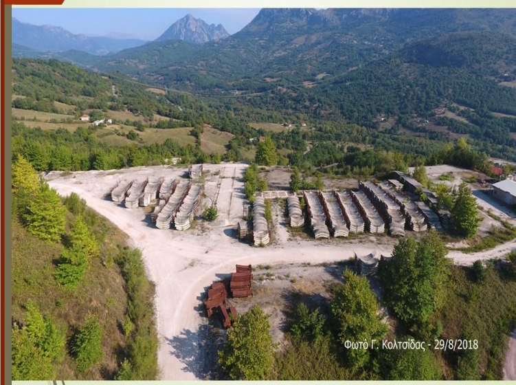
Γενική άποψη εργοταξίου σήραγγας μεταφοράς (Πευκόφυτο) (Προκατασκευασμένα στοιχεία επένδυσης σήραγγας)
