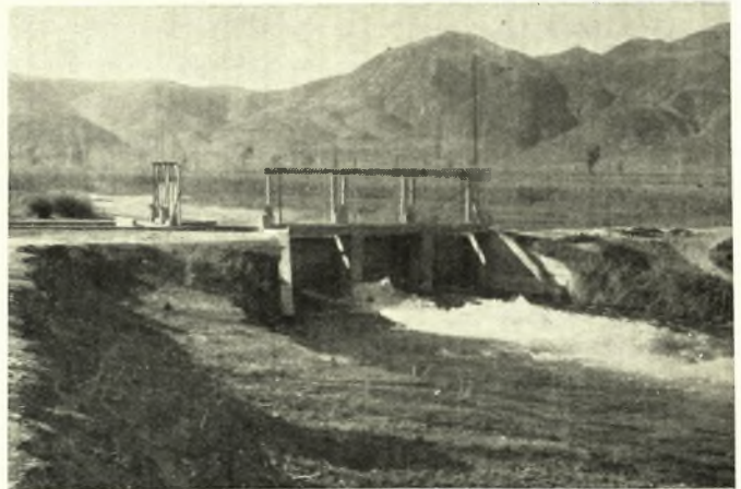
Φράγμα ἐκτροπῆς ὑδάτων εἰς Μάτι Τυρνάβου
