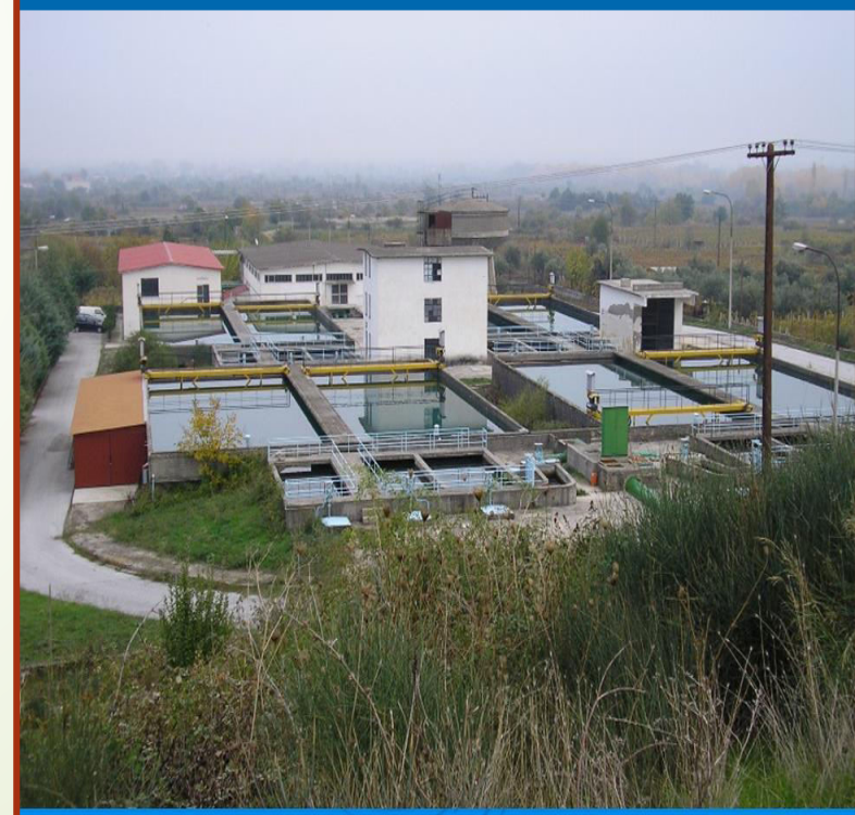
Διυλιστήρια Νερού Συνδέσμου Ύδρευσης Καρδίτσας
