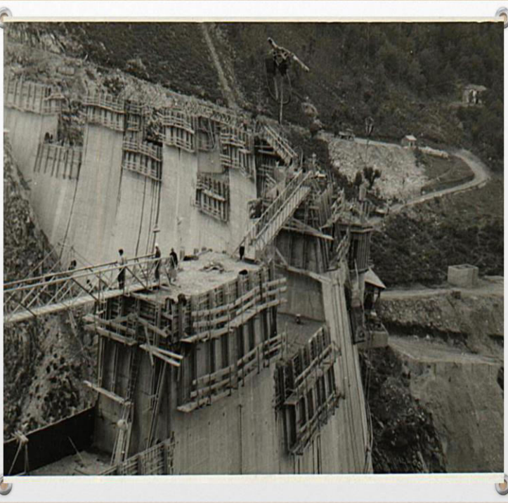
ΕΡΓΑΣΙΕΣ ΚΑΤΑΣΚΕΥΗΣ ΦΡΑΓΜΑΤΟΣ ΤΑΥΡΩΠΟΥ
