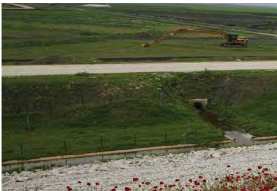
Εικόνα 3.44: Κατασκευαστικές εργασίες στον τεχνητό υγρότοπο της λίμνης Κάρλας
