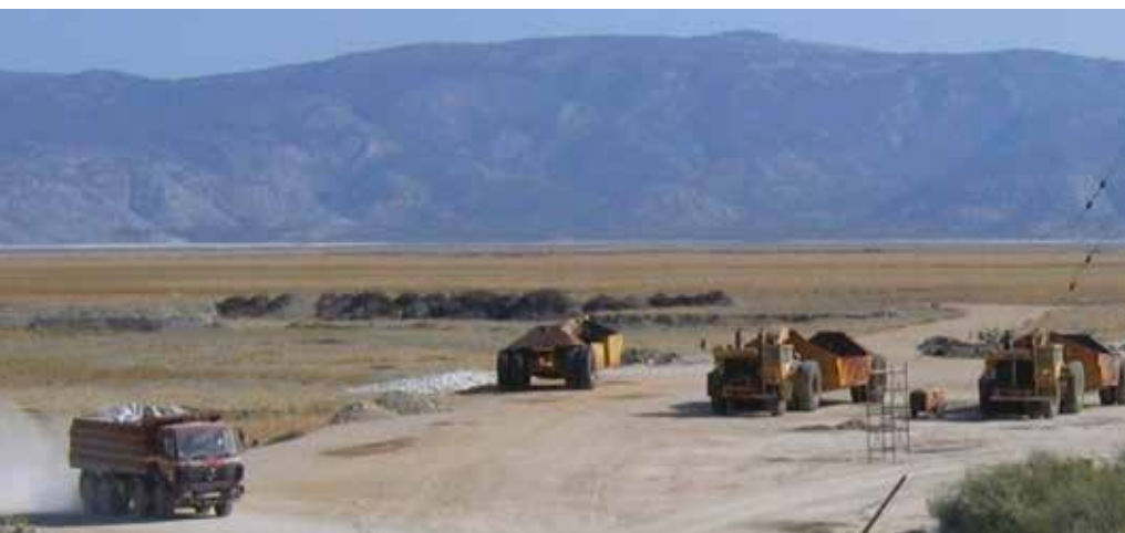
Εικόνα 2.12: Μερική απο- κατάσταση της λίμνης Κάρλας – Εργασίες πρώτης φάσης
