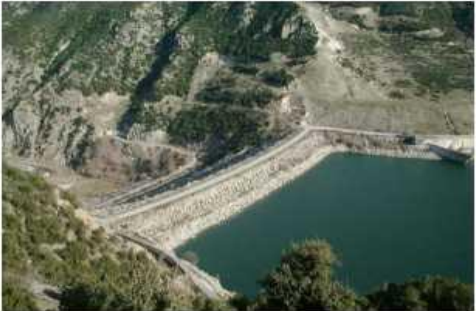
Εικόνα 3: Φράγμα ΥΗΕ Πολυφύτου
