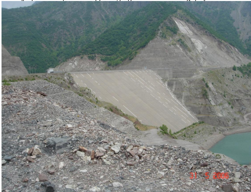
Φωτό 1. Φράγμα ΥΗΕ Μεσοχώρας, Όψη από ανάντη (2006)
