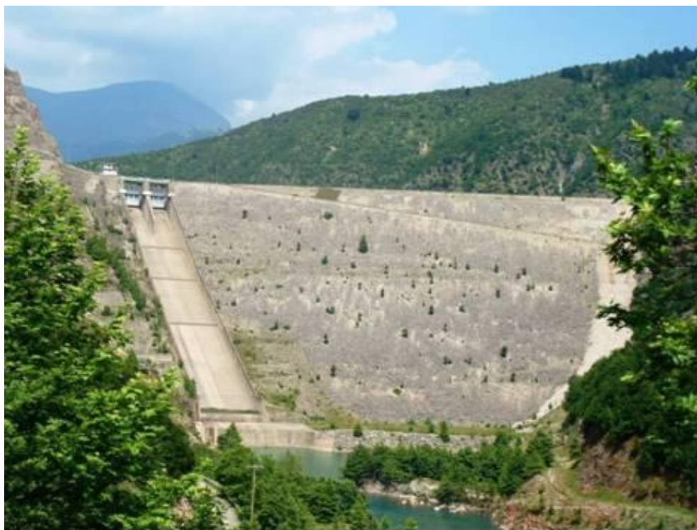
Φωτό 2. Φράγμα ΥΗΕ Μεσοχώρας, Όψη από κατάντη (2011)
