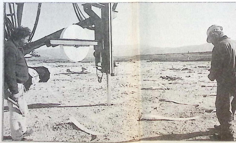
Το τρυπάνι της φωτογραφίας τοποθετεί ταινίες σε βάθος 10 μέτρων. Στο σημείο αυτό και σε έκταση 22 στρεμμάτων θα κατασκευασθούν τα αντλιοστάσια. Πάνω σε αναχώματα ύψους 7-8 μέτρων. Όταν το έδαφος συμπιεστεί από το βάρος των χωμάτων οι ταινίες θα επιτρέψουν το νερό που είναι εγκλωβισμένο στους αργιλώδεις πόρους του υπεδάφους, να βγει και έτσι δεν θα υπάρξει κίνδυνος για νέα καθίζηση
