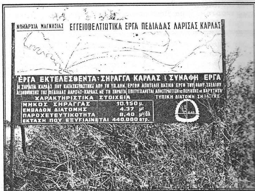
Τεχνικά, γεωτεχνικά και υδραυλικά στοιχεία της σήραγγας, όπως δωλώνονται σε πακτωμένη πινακίδα στην είσοδό της.
