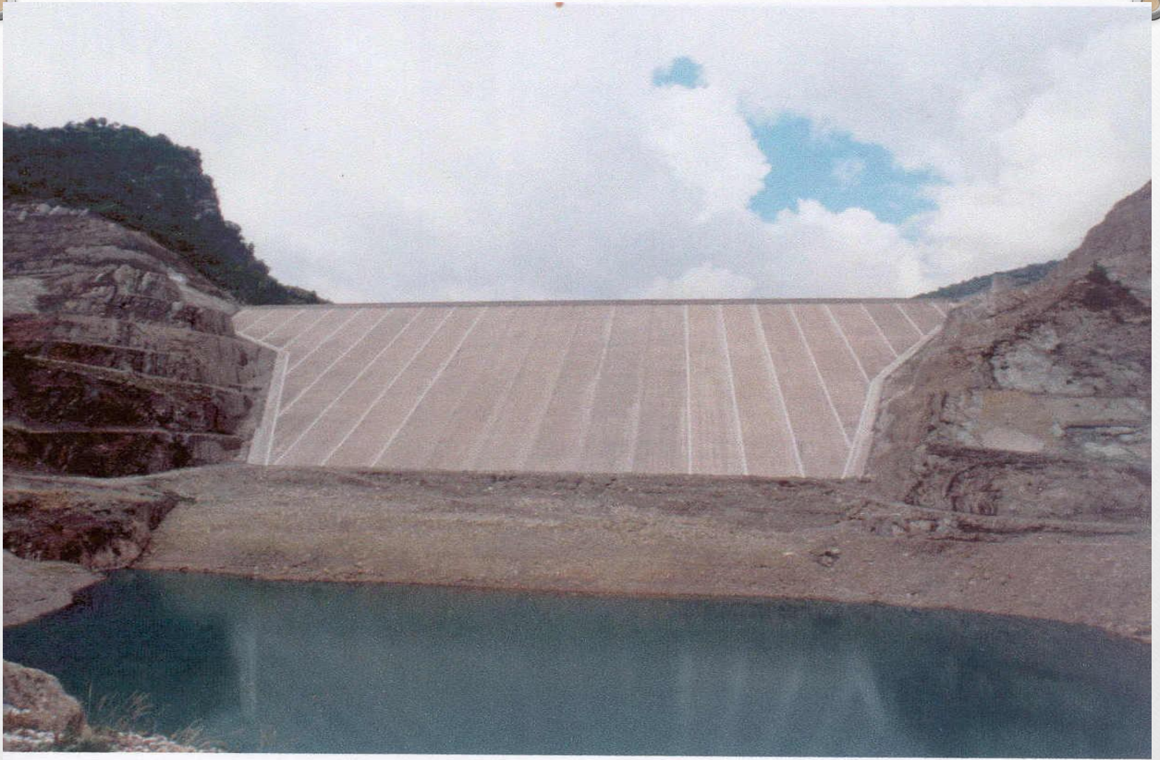
Ανάντη άποψη φράγματος
