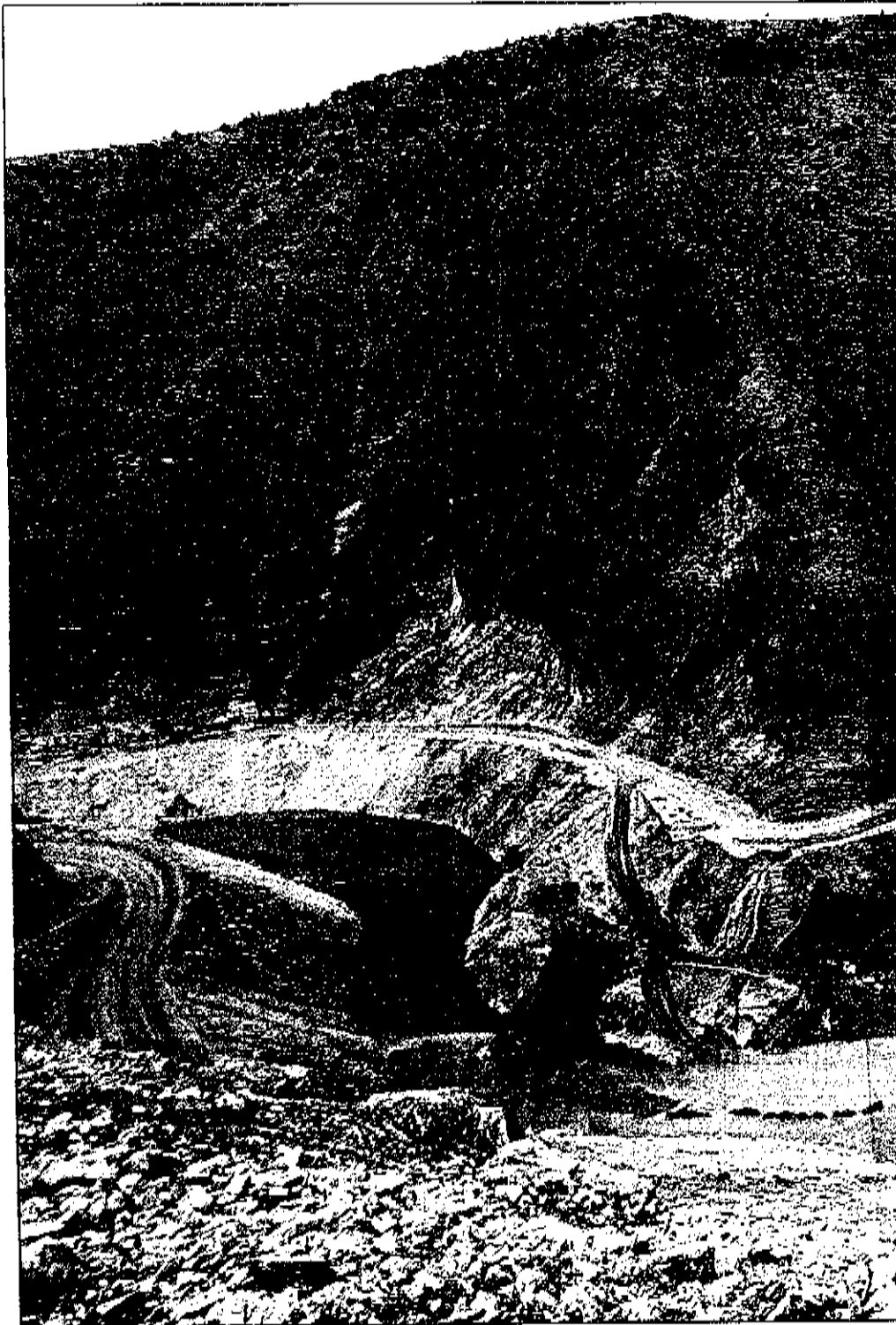
Γενική άποψη της Μεσοχώρας όπου τα έργα προχωρούν. Η περιοχή «ανήκει» στην αρμοδιότητα δραστηριοτήτων η ΔΕΗ αναπτύσσει και στη Σικιά. Άλλα τμήματα των έργων όμως
