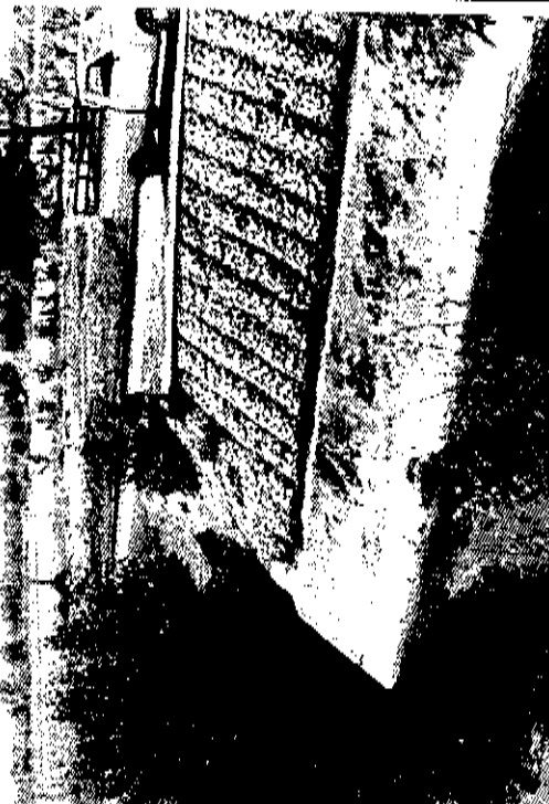
Οι πόρτες στο θυροφράγμα της λίμνης (πάνω) έχουν κυριολεκτικά σκουρίσει αφού τα τελευταία χρόνια παραμένουν πάντα ανοικτές. Το νερό χάνεται. Η δεύτερη φωτογραφία (κάτω), δείχνει τα φράγματα που έγιναν για να κρατήσουν κάποτε το νερό απ' την πλημύρα, αλλά και τη στάθμη του σήμερα.
