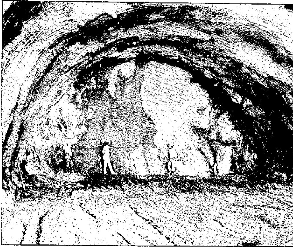
Μέτωπο σήραγγας εκτροπής του Υδροηλεκτρικού Σταθμού Σικιάς
