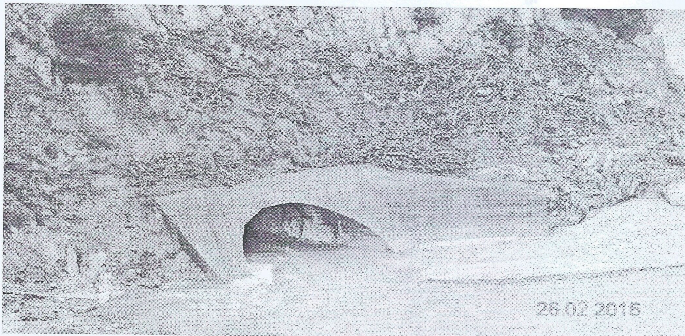
Εικόνα 2: Είσοδος σήραγγας εκτροπής Νο 2 Κουμπουριανίτικου ποταμού.
