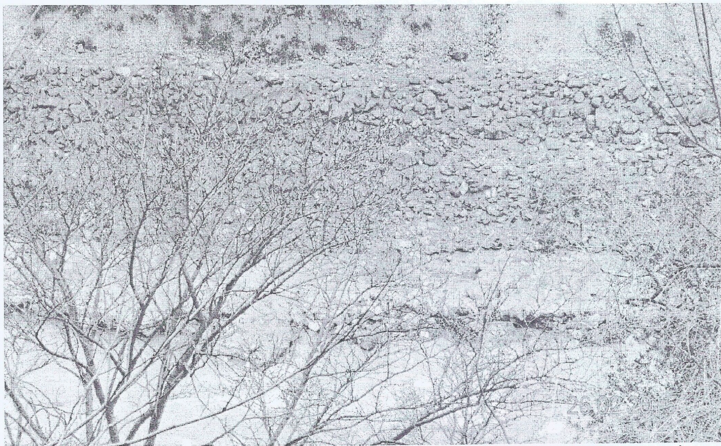
Εικόνα 6: Λιθόδεμα προστασίας της παραποτάμιας οδού στο δεξιό αντέρεισμα του Αχελώου ποταμού.
