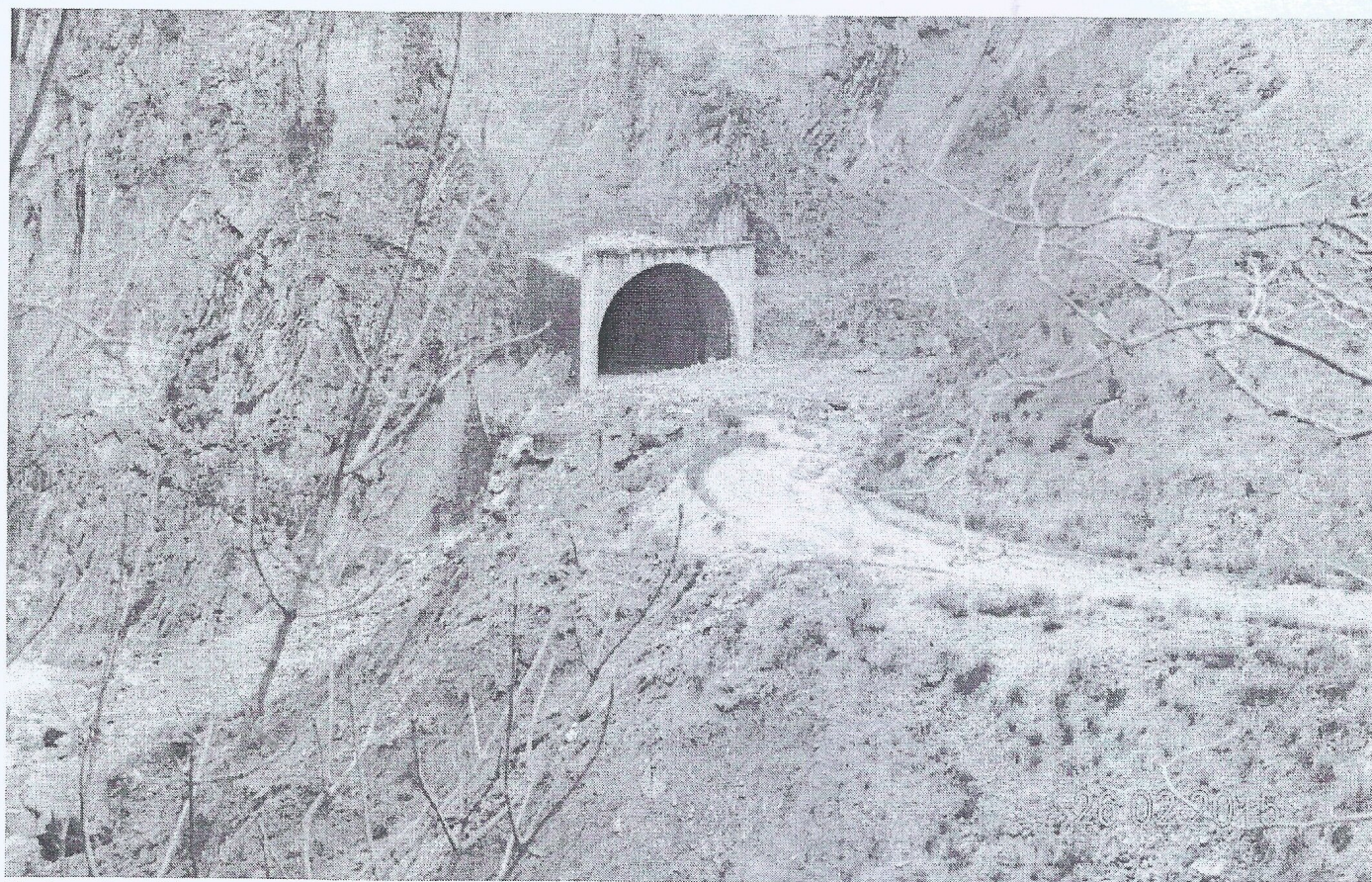
Εικόνα 5: Οδός προσπέλασης στο δεξιό αντέρεισμα του Αχελώου ποταμού.
