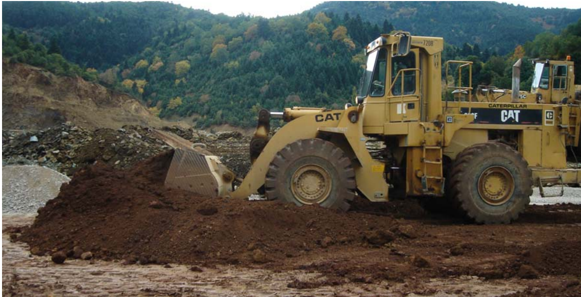
Φωτ. 3. Διάστρωση αργίλου προς κατασκευή του πυρήνα του αναχώματος.
