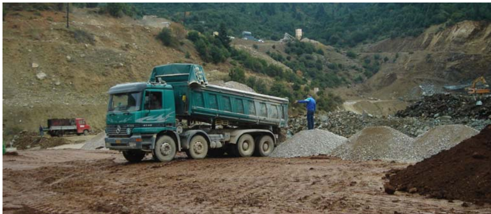
Φωτ. 7. Κατασκευή ζώνης στραγγιστηρίου κατάντη του πυρήνα του αναχώματος.
