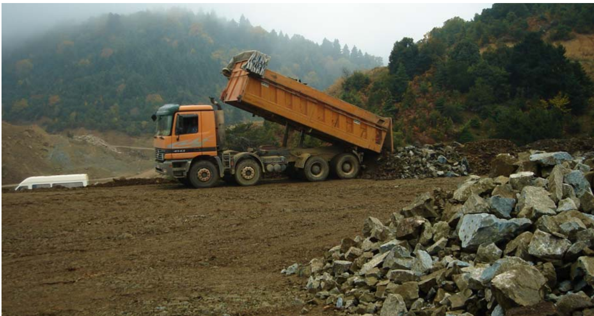
Φωτ. 11. Ανάντη σώμα στήριξης αναχώματος. Απόθεση υλικών εκσκαφής δανειοθαλάμου προς διάστρωση και συμπύκνωσή τους.
