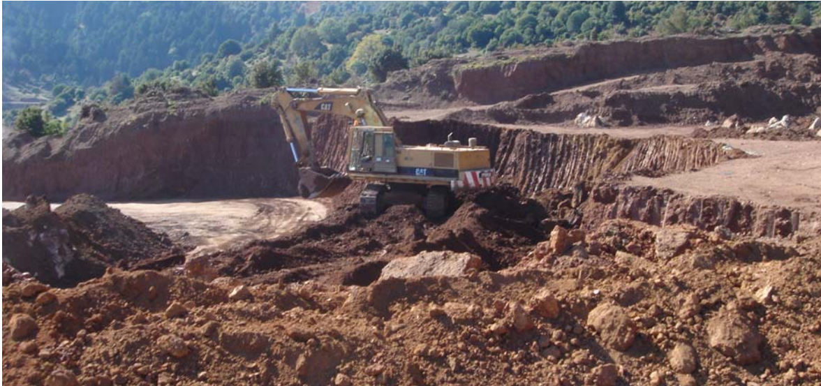
Φωτ. 2. Άποψη του δανειοθαλάμου αργίλου. Διακρίνεται η διαμόρφωση των βαθμίδων.
