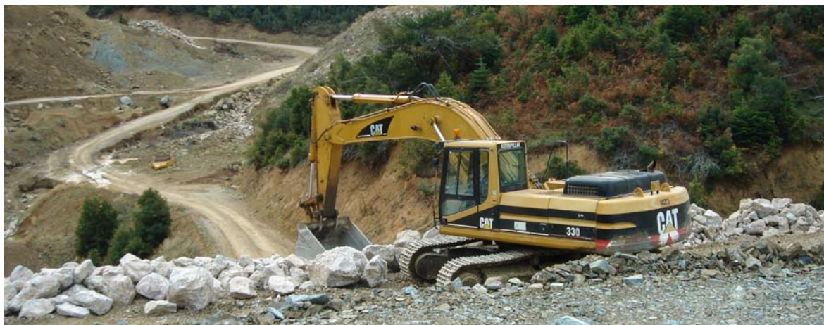
Φωτ. 17. Κατασκευή επένδυσης πρανούς ανάντη σώματος στήριξης με ευμεγέθεις λίθους (Rip – Rap).
