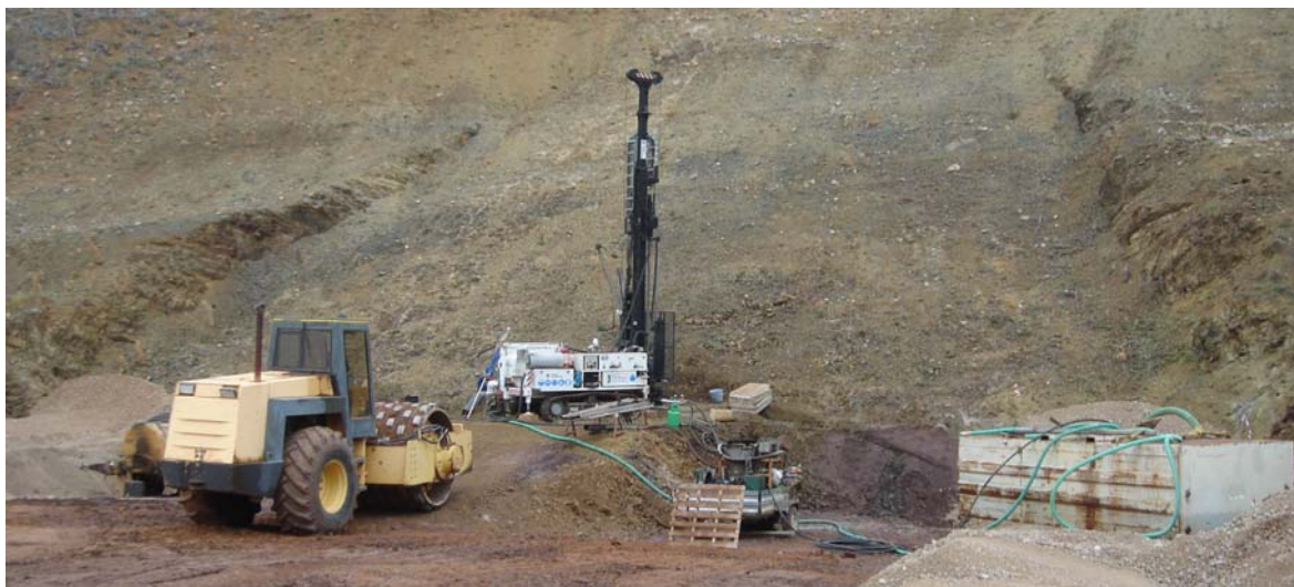
Φωτ. 14. Εξοπλισμός και διάταξη διάτρησης οπών της κουρτίνας τσιμεντενέσεων.
