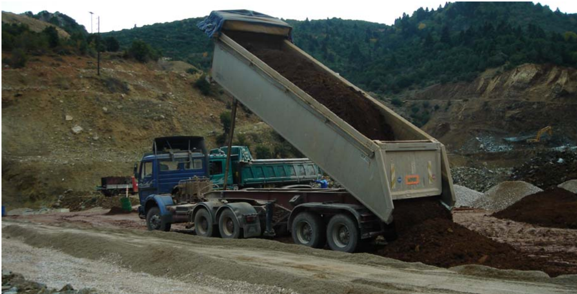
Φωτ. 2. Απόθεση αργίλου προς κατασκευή του πυρήνα του αναχώματος.
