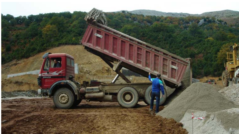
Φωτ. 8α & 8β. Κατασκευή ζώνης φίλτρου ανάντη και κατάντη του πυρήνα του αναχώματος.
