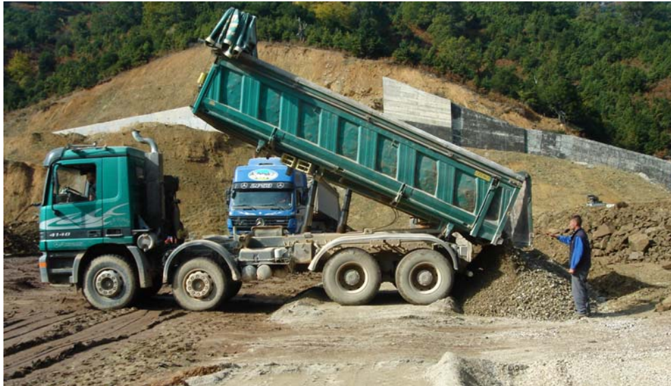
Φωτ. 7. Κατασκευή ζώνης στραγγιστηρίου κατάντη του πυρήνα του αναχώματος.
