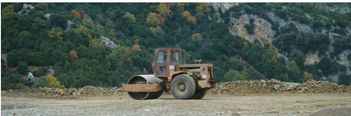
Φωτ. 13α & 13β. Ανάντη σώμα στήριξης αναχώματος. Διάστρωση και συμπίκνωση διαστρωμένων υλικών εκσκαφής δανειοθαλάμου.
