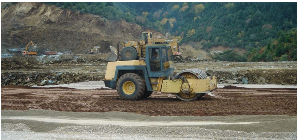
Φωτ. 5. Συμπύκνωση αργίλου με «κοπανοφόρο» δονητή.
