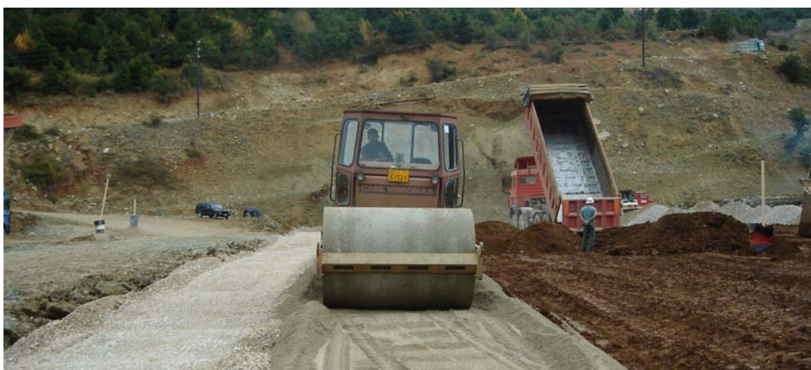
Φωτ. 9α, 9β & 9γ. Ζώνες φίλτρου και στραγγιστηρίου. Διάστρωση και συμπίκνωση.
