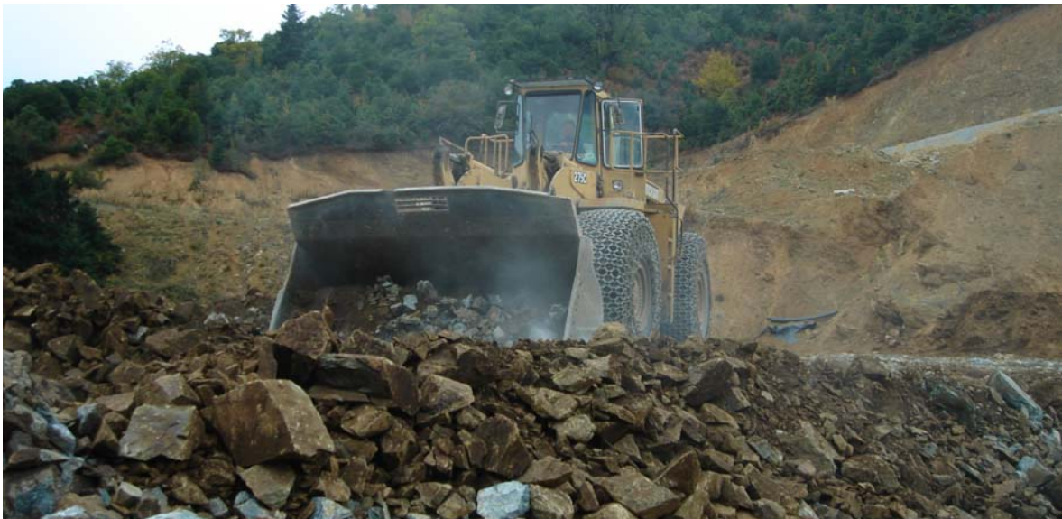
Φωτ. 12. Καπάντη σώμα στήριξης αναχώματος. Απόθεση υλικών εκσκαφής δανειοθαλάμου προς διάστρωση και συμπίκνωσή τους.
