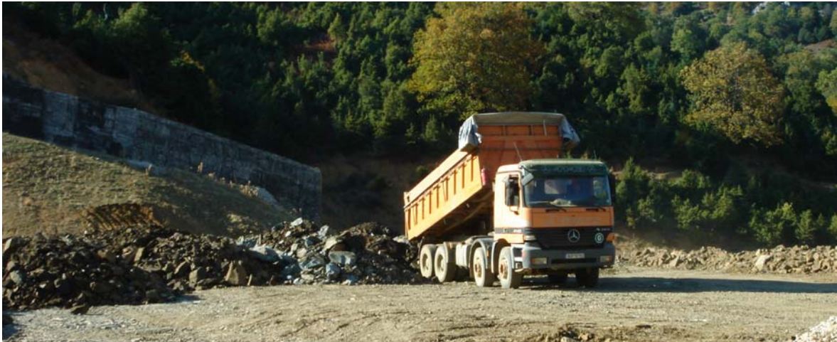
Φωτ. 12. Καπάντη σώμα στήριξης αναχώματος. Απόθεση υλικών εκσκαφής δανειοθαλάμου προς διάστρωση και συμπίκνωσή τους.
