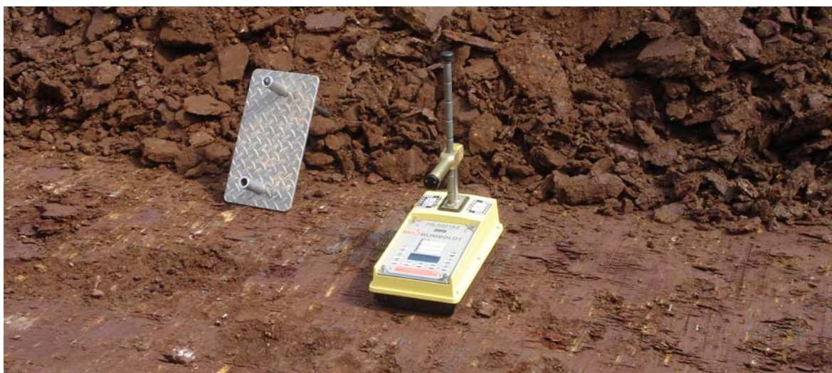
Φωτ. 19. Επί τόπου μέτρηση της πυκνότητας του πυρήνα με την συσκευή ακτίνων γ – ραδιοϊσοτόπων.
