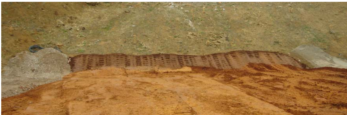
Φωτ. 4. Άποψη διαμόρφωσης του στρώματος αργίλου στα αντερείσματα.
