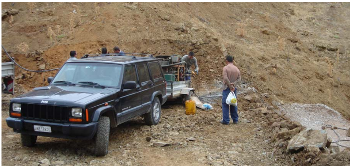
Φωτ. 15. Εξοπλισμός και διάταξη εισπίεσης τσιμεντενέματος στις οπές του τάπητα και της κουρτίνας τσιμεντενέσεων.
