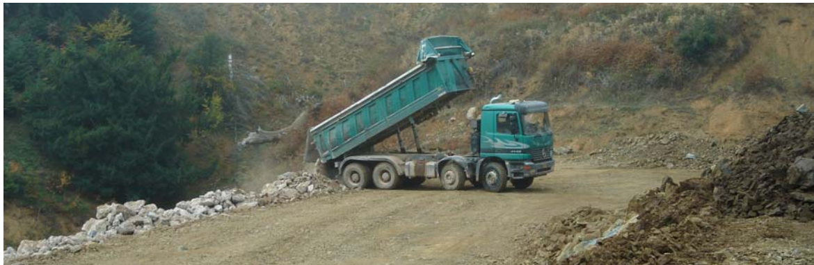
Φωτ. 16. Απόθεση ευμεγέθων λίθων (Rip – Rap) προς κατασκευή της επένδυσης του πρανούς του ανάντη σώματος στήριξης.
