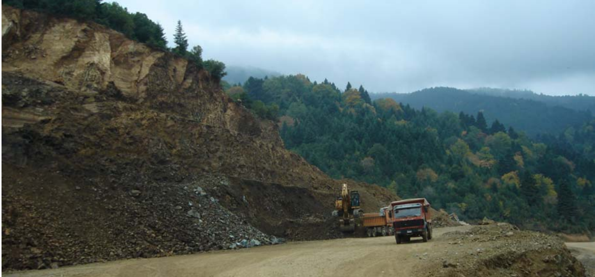
Φωτ. 10 Γενική άποψη δανειοθαλάμου υλικών κατασκευής σωμάτων στήριξης. Διακρίνεται η καταρχήν διαμόρφωση των βαθμίδων.
