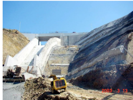
Εικόνες 7 και 8: Αστοχία κατά την εκσκαφή του εκχειλιστή και τελικά μέτρα προστασίας
