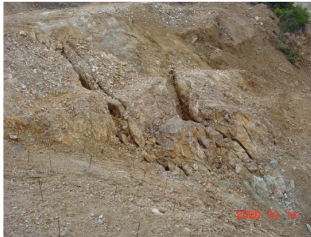
Εικόνες 7 και 8: Αστοχία κατά την εκσκαφή του εκχειλιστή και τελικά μέτρα προστασίας
