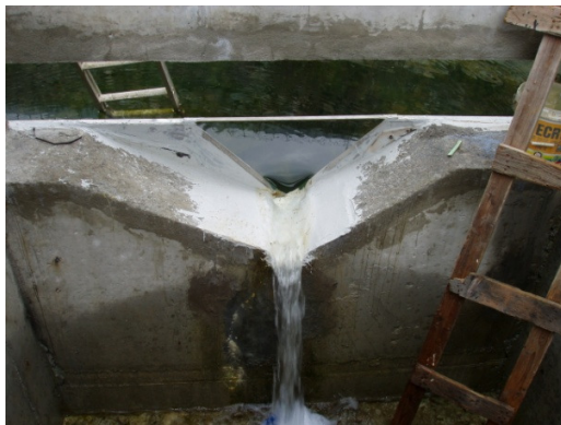
Μέτρηση διαρροών στα κατάντη
