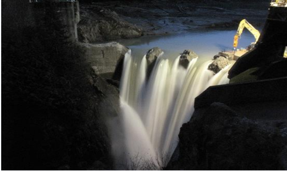
Εικόνα: Καθαίρεση του φράγματος Eilwha Η.Π.Α (2012)
